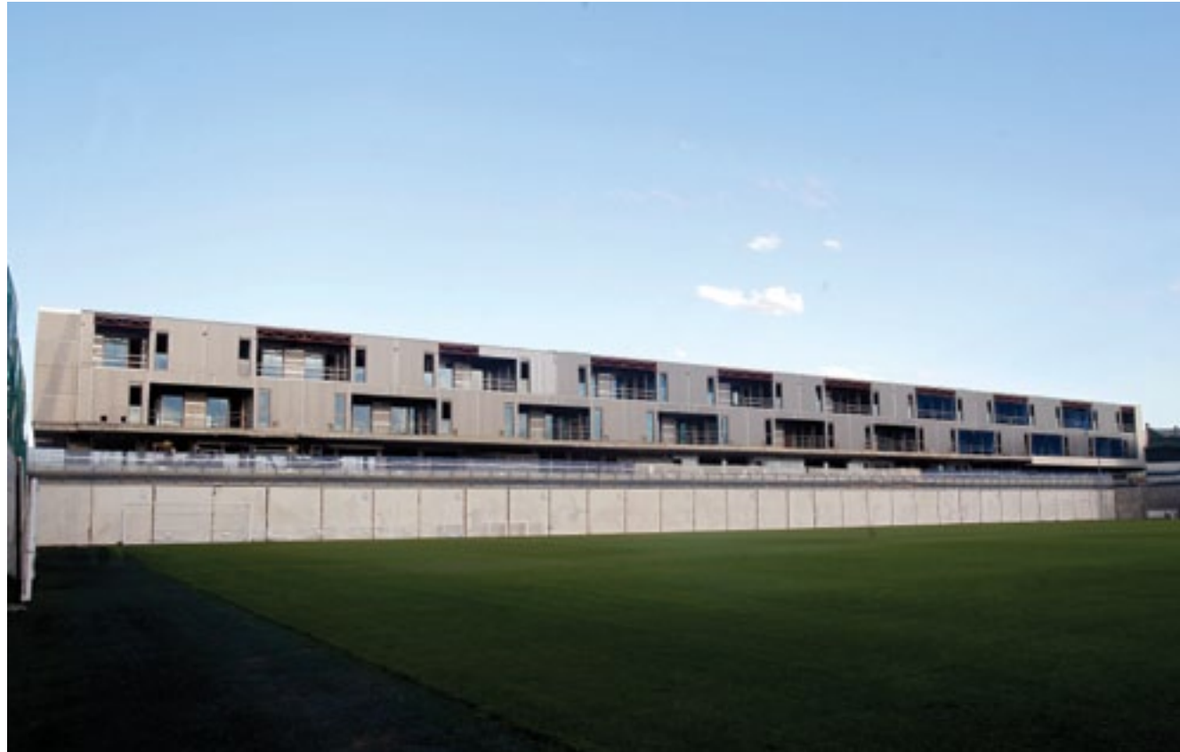
Estado actual de las obras de la residencia del primer equipo.
